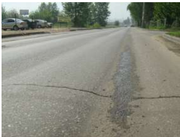
Участок автомобильной дороги по ул. Гаврилова
